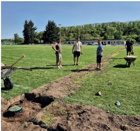
*Da ist guter Rat teuer – kurze Verschnaufpause beim Einbauen der Ventile zur Steuerung der insgesamt 5 Stichleitungen*
